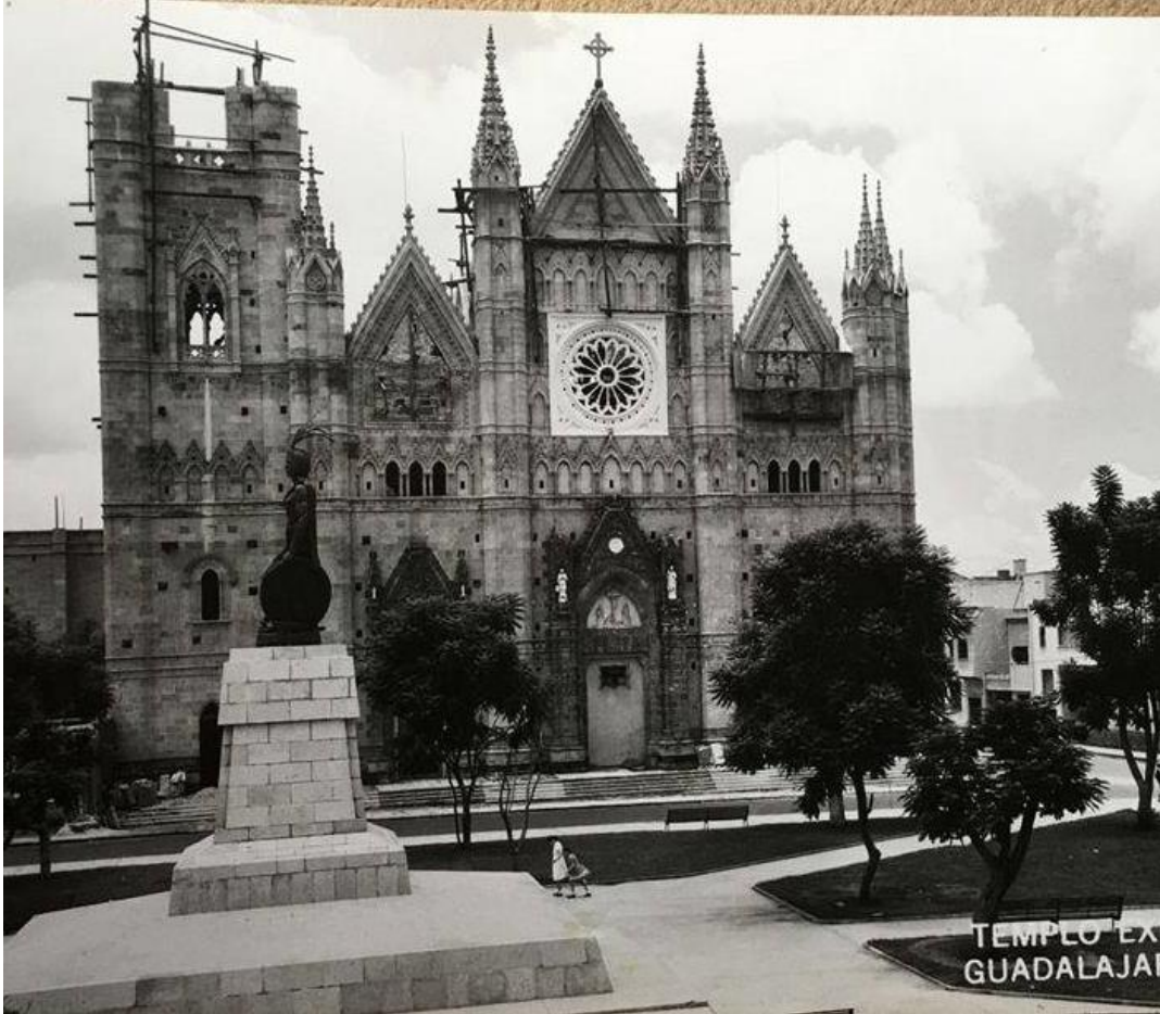
Figure 1.3. Templo Expiatorio in final stages of construction, c. 1960. Photo courtesy of the Archivo Municipal de Guadalajara.
